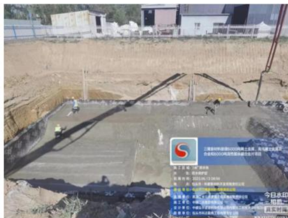
事故池防渗施工
