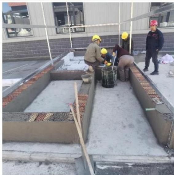
危废暂存间防渗施工
